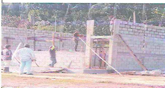
Foto 5: Se ve el avance al 75%.
