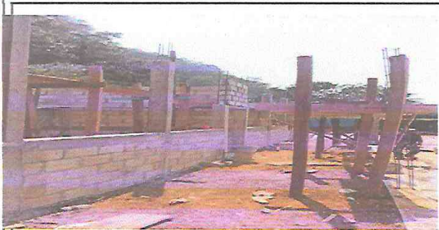
Foto 1: Vista frente del modulo 1
