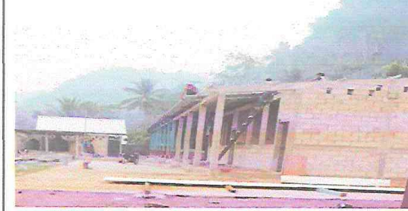
Foto 4: Se observa la calidad de la obra.
